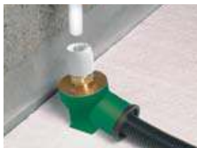
Fig. 45 HX101/15 conduit terminal installation procedure
