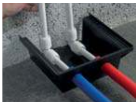
Fig. 38 Cut conduit box for wall termination
